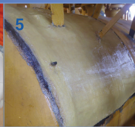
5 Aplicação dos patches de Kevlar® com resina 3X
