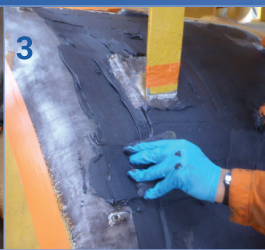
3 Aplicação do preenchimento 3X (3X filler)
