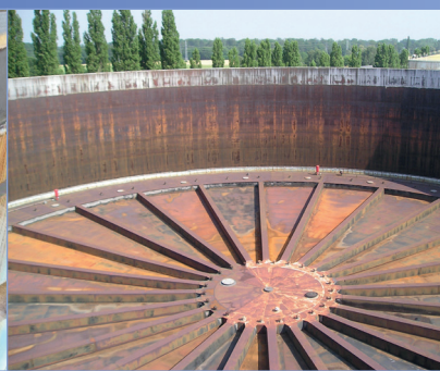
PERFURAÇÃO E VAZAMENTO
