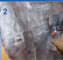
2 Preparação de superfície Sa2½ / St3 e rugosidade Rz > 60 µm
