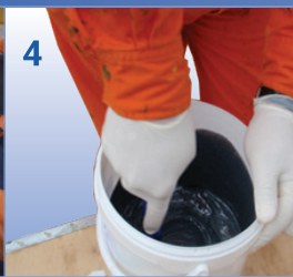
4 Preparação da resina epóxi bicomponente 3X
