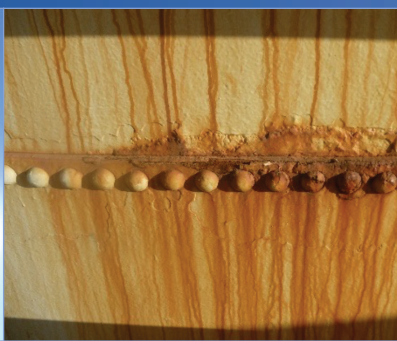
CORROSÃO INTERNA
